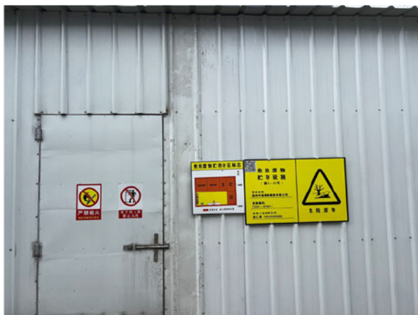
图 4.6.1-2 危险废物贮存设施警示标志牌现状图
