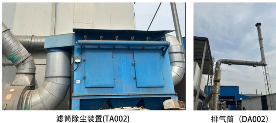
图 4.1-2 滤筒除尘装置及排气筒
