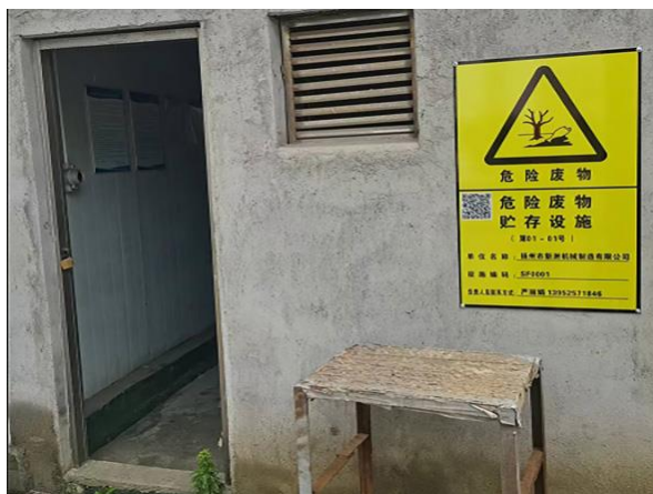
图 4.7.1-2 危险废物贮存设施警示标志牌现状图
