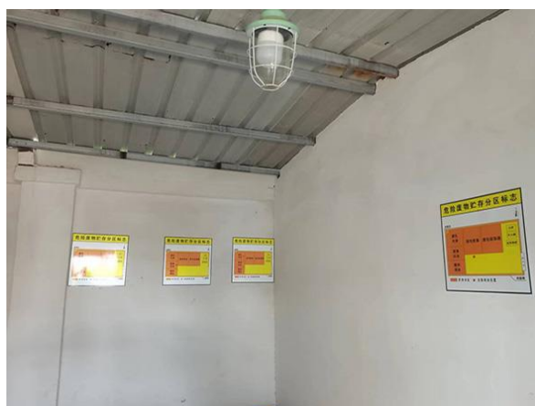
图 4.7.1-3 危险废物贮存设施内部分区警示标志牌现状图
