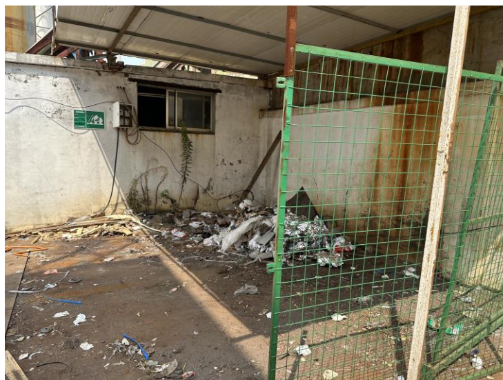
图 4.7.2-1 建设单位一般固废库现状图
