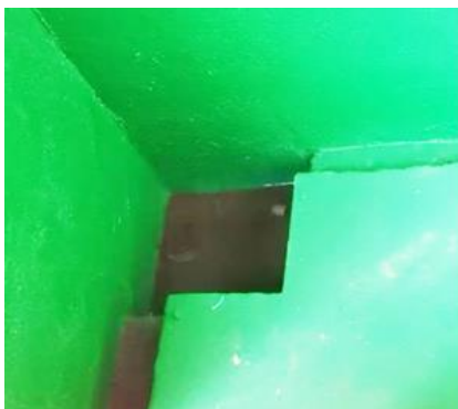
导流槽、收集坑
