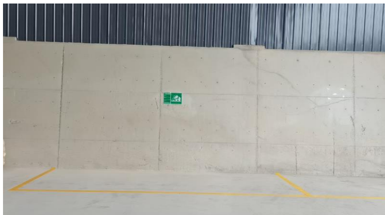
图 4.6.2-1 建设单位一般固废库现状图
