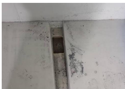
导流槽、收集孔
