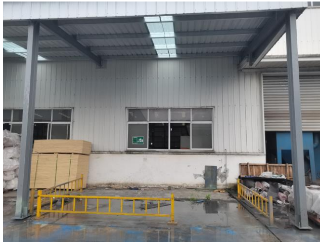
图 4.6.2-1 建设单位一般固废库现状图
