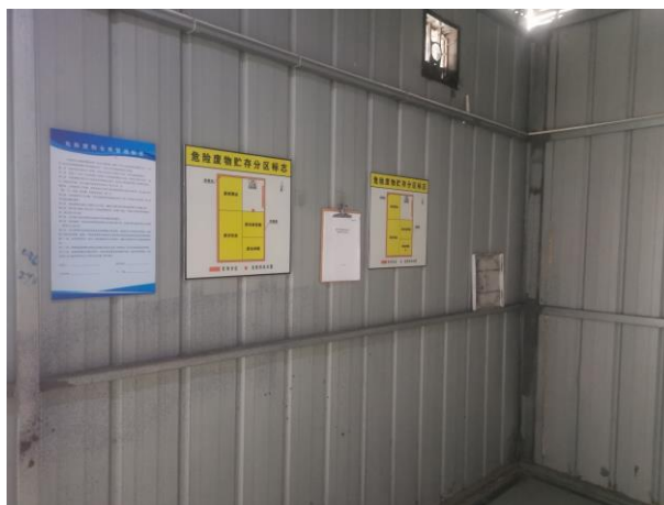
图 4.7.1-3 危险废物贮存设施内部分区警示标志牌现状图
