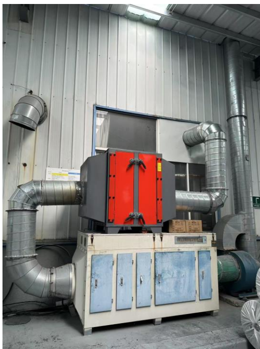
图 4.1-1 熔融挤出、整经上油废气两级活性炭吸附装置及排气筒
