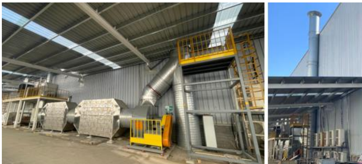
图 4.1-1 涂胶、喷胶、烘干废气处理装置 TA001 及排气筒 DA001
