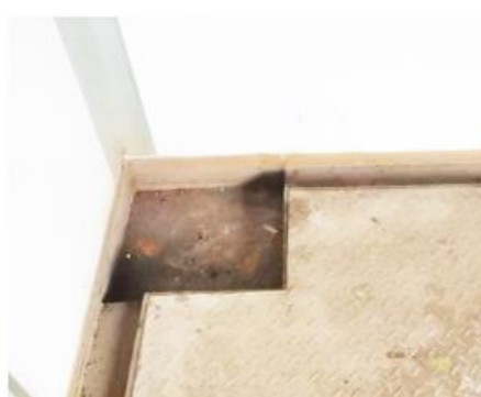
导流槽、收集坑
