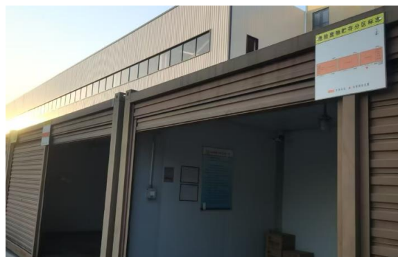
图 4.7.1-3 危险废物贮存分区标志牌现状图
