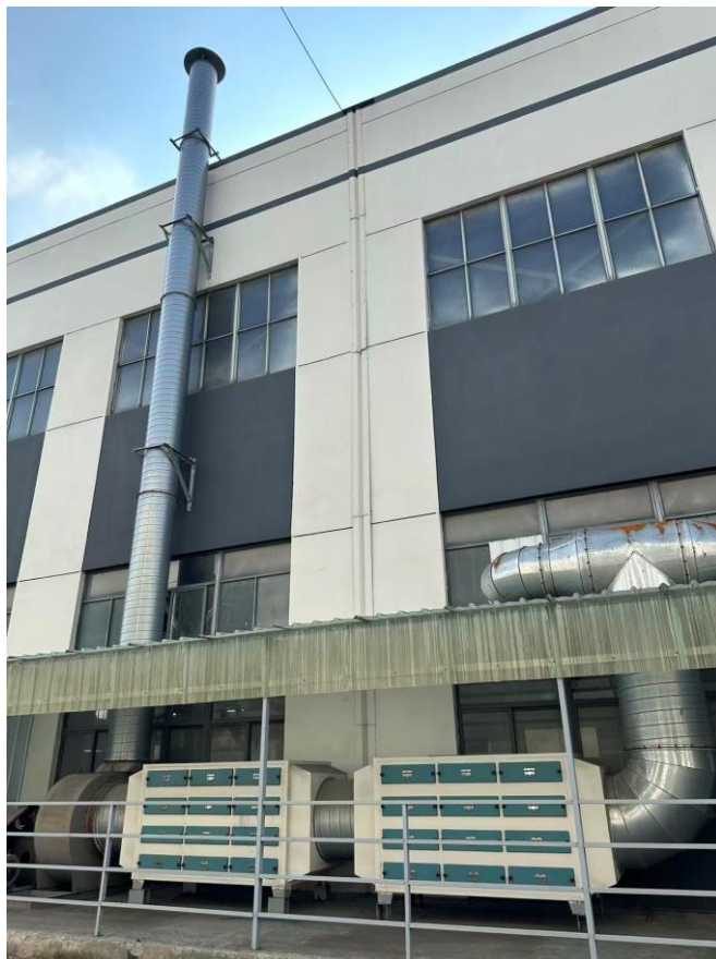
图 4.1-1 过滤棉+二级活性炭吸附装置及排气筒
