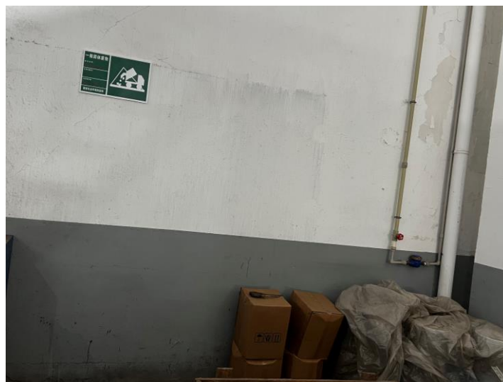
图 4.6.2-1 建设单位一般固废库现状图
