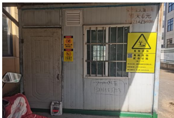
图 4.6.1-2 危险废物贮存设施警示标志牌现状图
