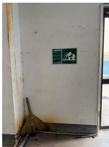
图 4.6.2-1 建设单位一般固废库现状图
