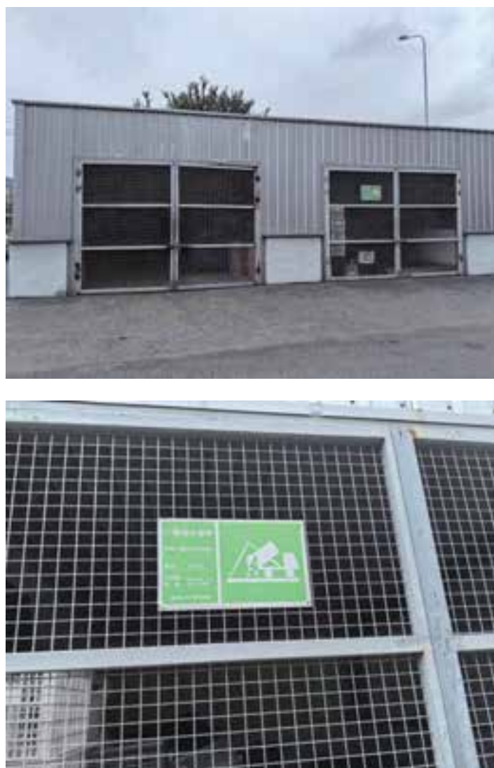
图 4.7.2-1 建设单位一般固废库现状图
