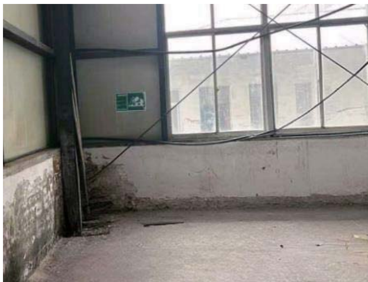
图 4.6.2-1 建设单位一般固废库现状图
