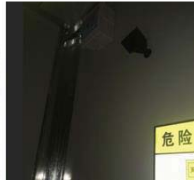
危废库内摄像头
