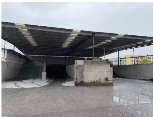
图 4.7.2-1 建设单位一般固废库现状图
