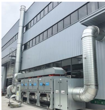
图 4.1-2 喷漆、晾干废气处理装置 TA002 及排气筒 DA002
