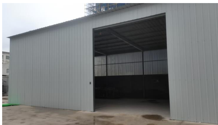
图 4.6.2-1 建设单位一般固废库现状图
