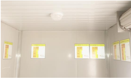
图 4.6.1-3 危险废物贮存分区标志牌现状图
