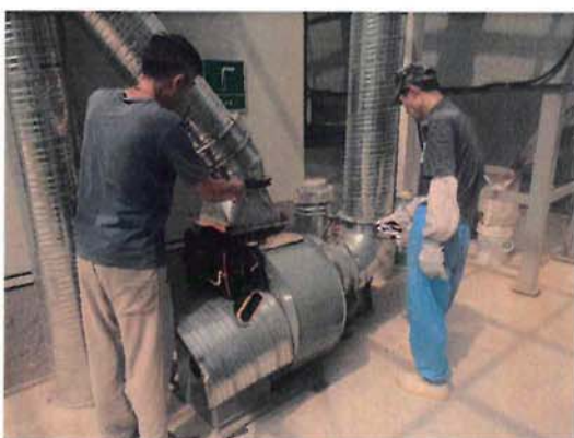
通知维修员工现场应急处置
