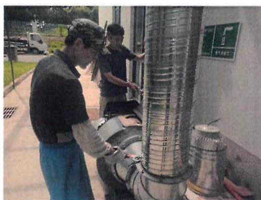
现场进行环保应急处置
